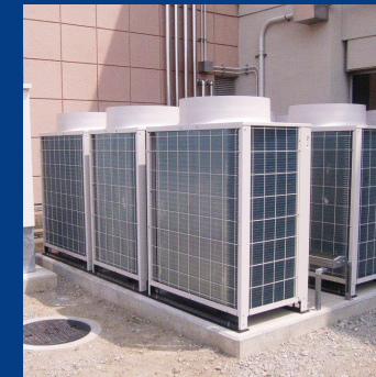
空調設備工事
