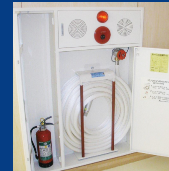
消火設備工事
