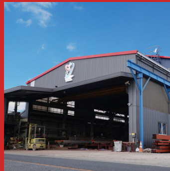
自社鉄骨工場
